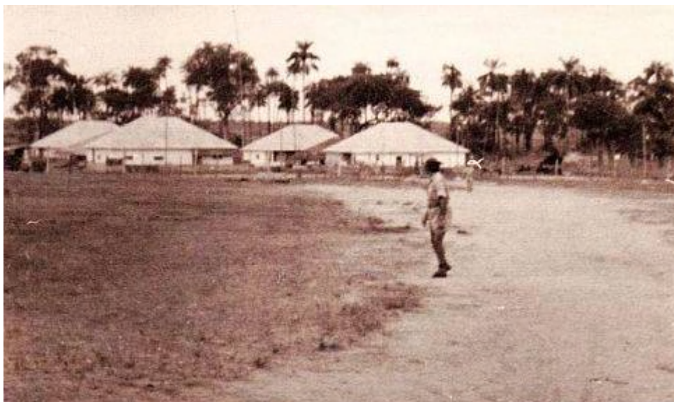
aspecto da sede da 4 o CCacI, aquartelada nas antigas instalações dos Serviços Provinciais Anti-Sezonáticos (visto da povoação de Amedalai)
