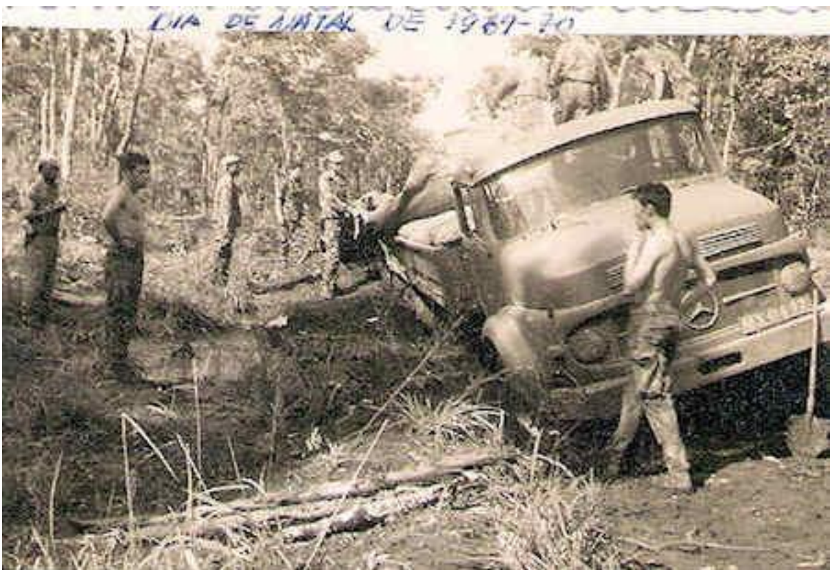
Ilustração 2 Começar a descarregar sacos de cimento.
