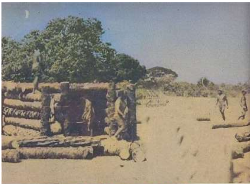
Pormenor dos trabalhos de organização de um abrigo
